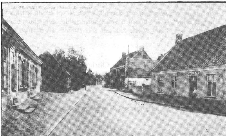
De herberg „In de Klok” op de Kleine Plaats in Lotenhulle. (Foto L. de Craene.)
