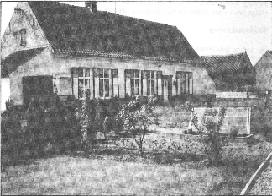
De hoeve met ernaast het stokerijgebouw langs de Steenweg op Aalter. Het gebouwencomplex wordt in de volksmond „de stokerij” genoemd. (Foto A. Strobbe.)
